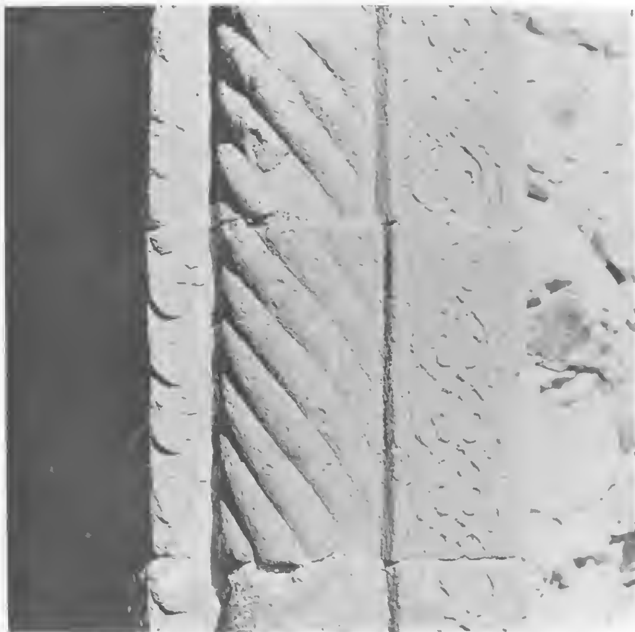
FIG. 15. — Adilcevaz-Altziké : détail du porche.
